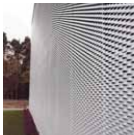
FACCIATA IN LAMIERA STIRATA VERNICIATA. PROGETTO DI RIQUALIFICAZIONE DI UN CAPANNONE INDUSTRIALE - GERMANIA FACADE IN LACQUERED EXPANDED METAL. PROJECT FOR RETRUCTURING OF AN INDUSTRIAL BUILDING - GERMANY
